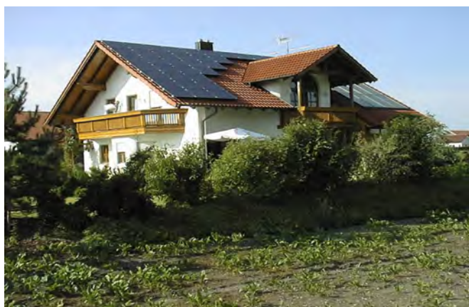
Vivienda unifamiliar en Bayern, con 5 kWp de paneles FV del programa alemán “100,000 tejados” [Fuente: https://live.pege.org/2001-pilsting/pflegau-41.htm ]
