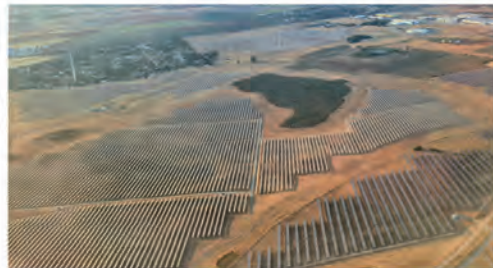
Vista aérea de plantas PV instaladas sobre suelo entre Carmona y Sevilla
