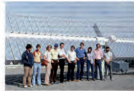
Primera planta PV de 1 MW de potencia, en California (1982), con seguimiento a dos ejes y lentes Fresnel [Fuente: Sunpower]
