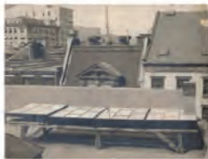
Primera instalación fotovoltaica en una cubierta de Nueva York (1884), realizada por C. Fritts [Fuente: J. Perlin, Let it shine: the 6,000-year story of solar energy , New World Library, 2013]
