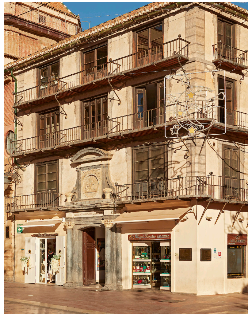
Fachada de la Casa del Consulado (2023)
